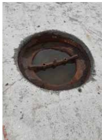
Betong – slípað og reinsað
