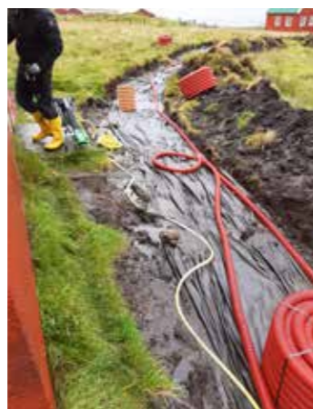
Rør eru lögð og káplar drignir eftir gøtuni
