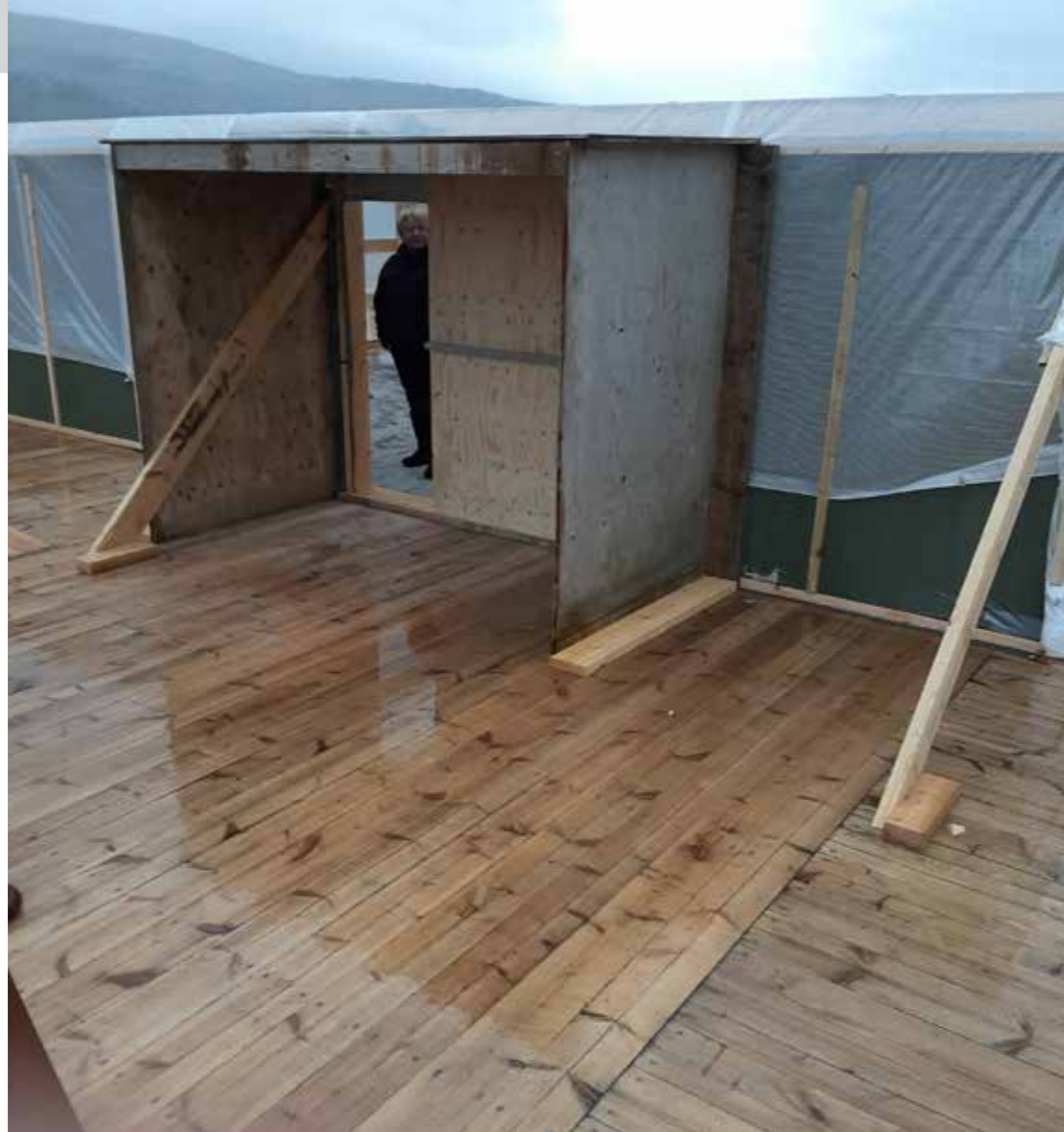
Eitt skyli varð riggað til, soleiðis at tað var turt at leggja epoxy á
