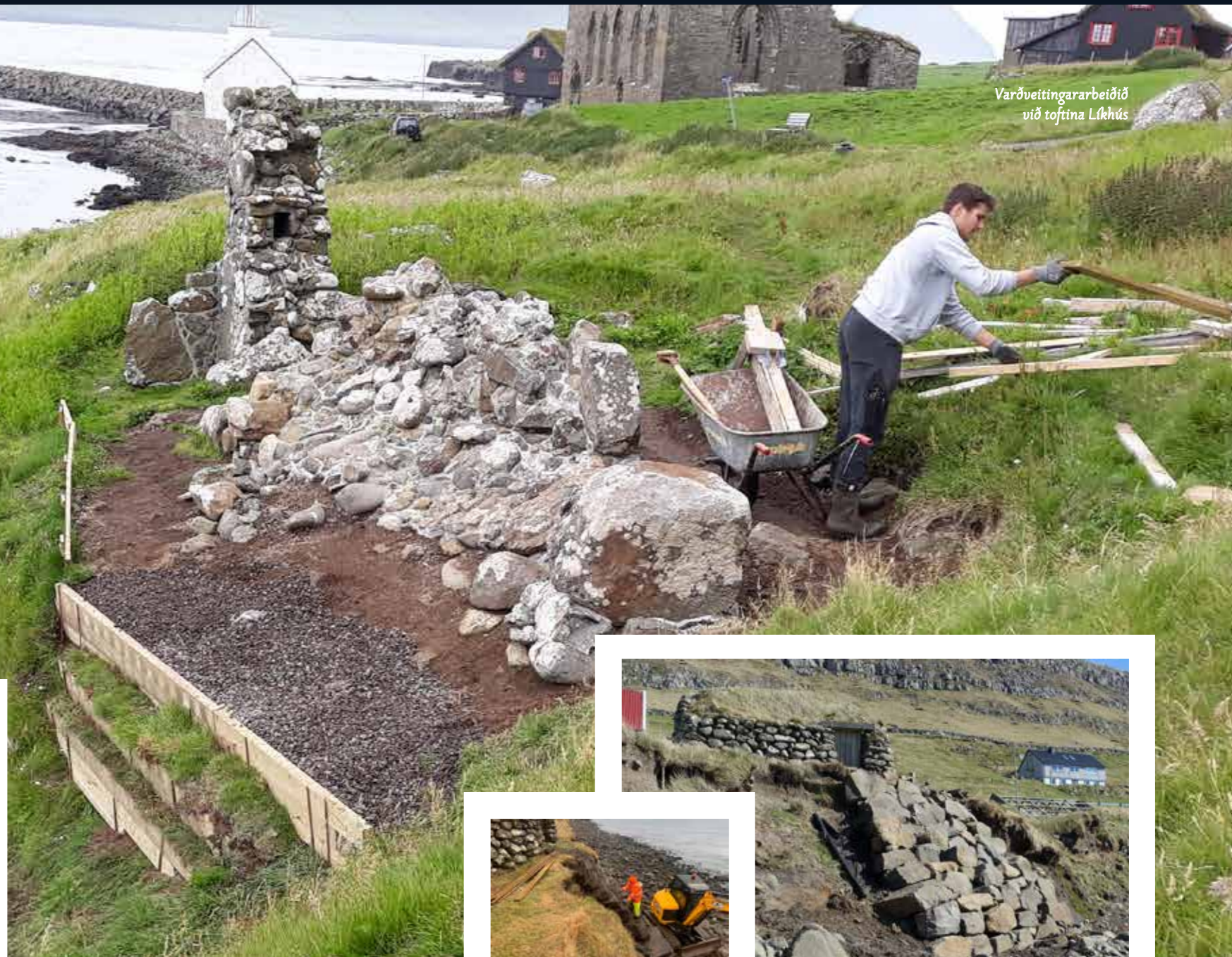
Fótur, stoyptur undir gomlu bakkaverjuna frá 1942 undir Líkhúsi í Kirkjubø
