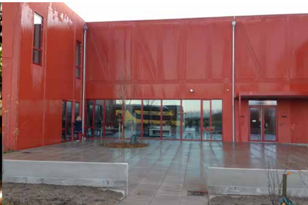
Bevaringscenter Sønderjylland innan. Mynstur er gjørt í betongið, so tað líkist einum bindingsverkshúsi
